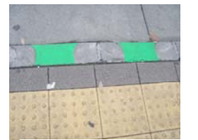
塗り替え作業後
