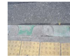
塗り替え作業前
