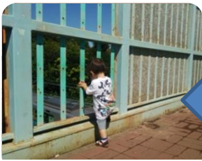
補修前の歩道橋
